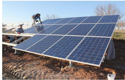
Şekil 7. Fotovoltaik panellerin araziye montajı
