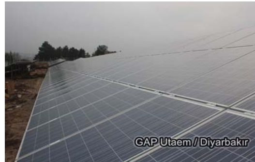
Şekil 8. GES kurulununun tamamlanması
